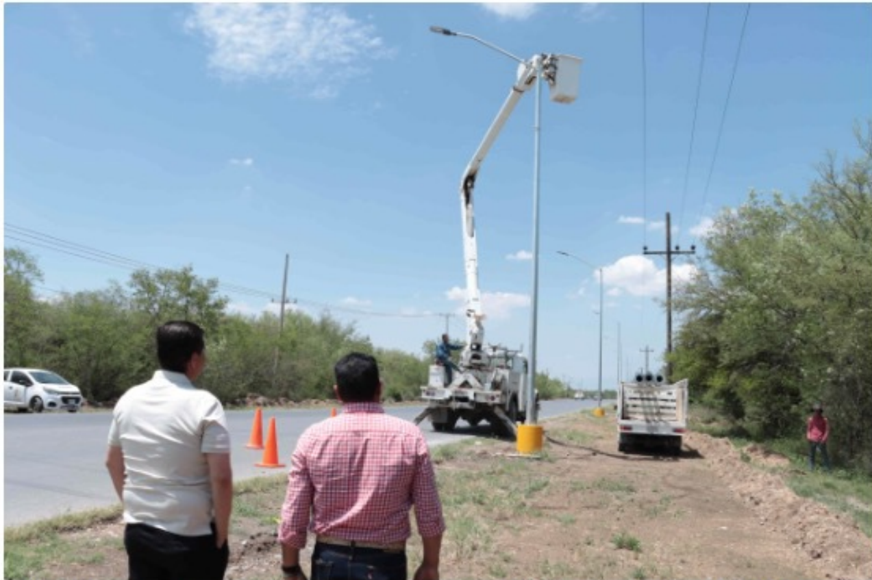
El alcalde de Juárez, Francisco Treviño Cantú supervisó los trabajos de una mega obra para iluminar 11 kilómetros de la carretera a San Mateo. FOTO: Cortesía
